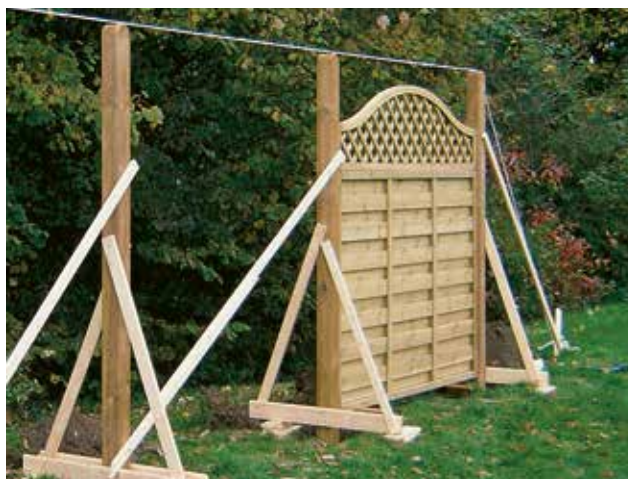
Die genaue Längsausrichtung klappt mit einer Spannschnur.
