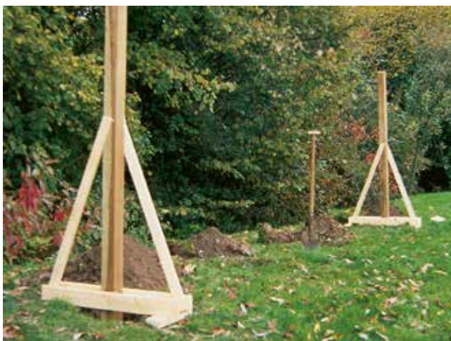
Montagehilfe zur Ausrichtung von Sichtblenden-Modulen
